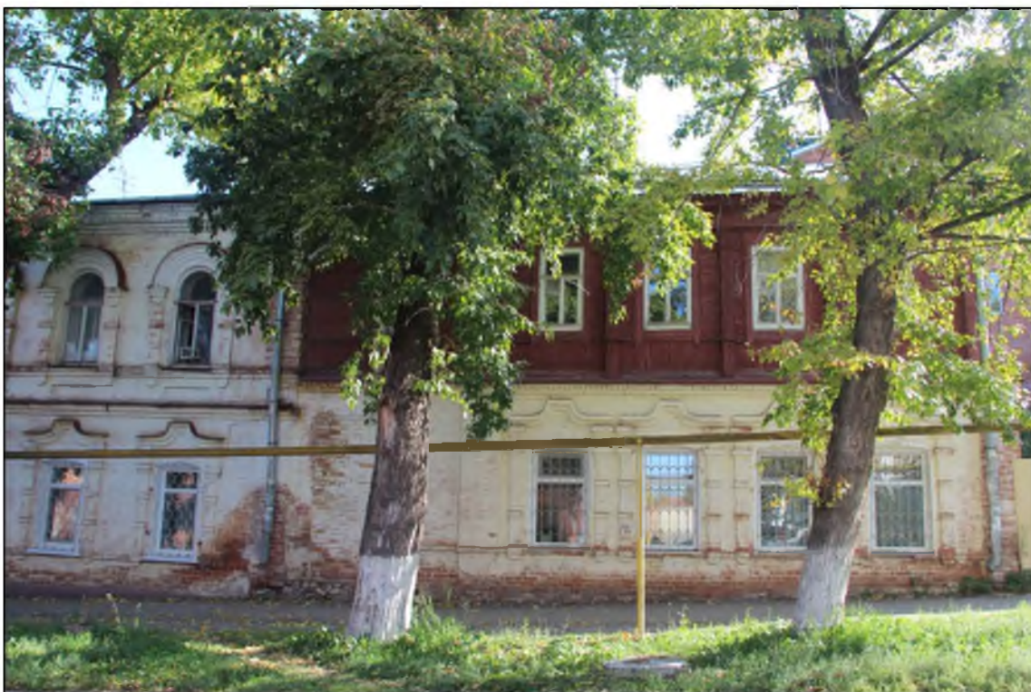
г. Ульяновск, ул. Андрея Блаженного, 34. Вид с улицы Александра Матросова на юго-западный фасад (фрагмент) каменного двухэтажного дома и фасад полукаменного флигеля. Современное фото.
