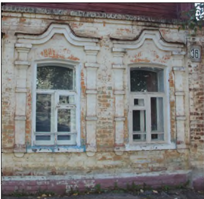
Окна первого этажа дома № 36 по ул. Андрея Блаженного.
